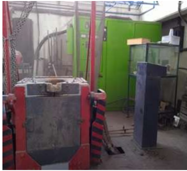
Figura 3.8. Horno de inducción con capacidad de 250 kg utilizado para el proceso de fusión del acero.
