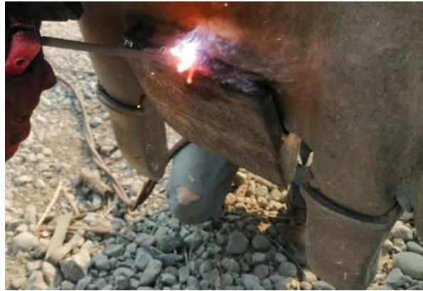
Figura 4.34. Soldadura en campo de los protectores de labio en la cuchara.
