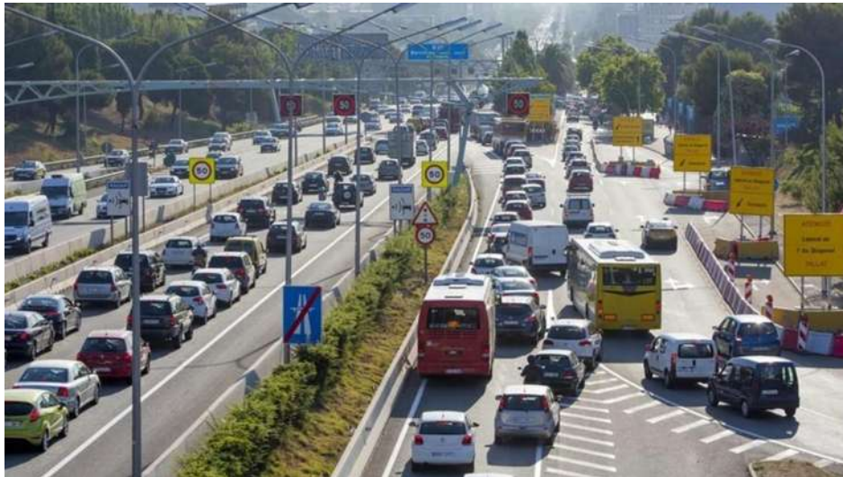
Figura 12. Cuello de botella provocado por incorporación de carriles laterales a centrales. (drivesmart,2019)
