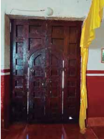
Figura 39. Puerta de acceso lateral interior. Fotografía: Saleta Lizbeth Vargas Viveros.
