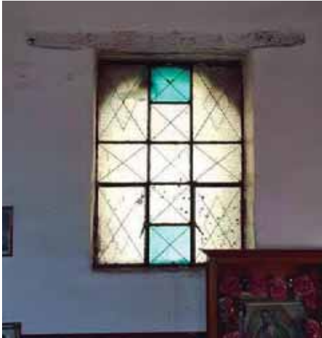
Figura 33. Herrería interior en vano de ventana. Fotografía: Saleta Lizbeth Vargas Viveros.
