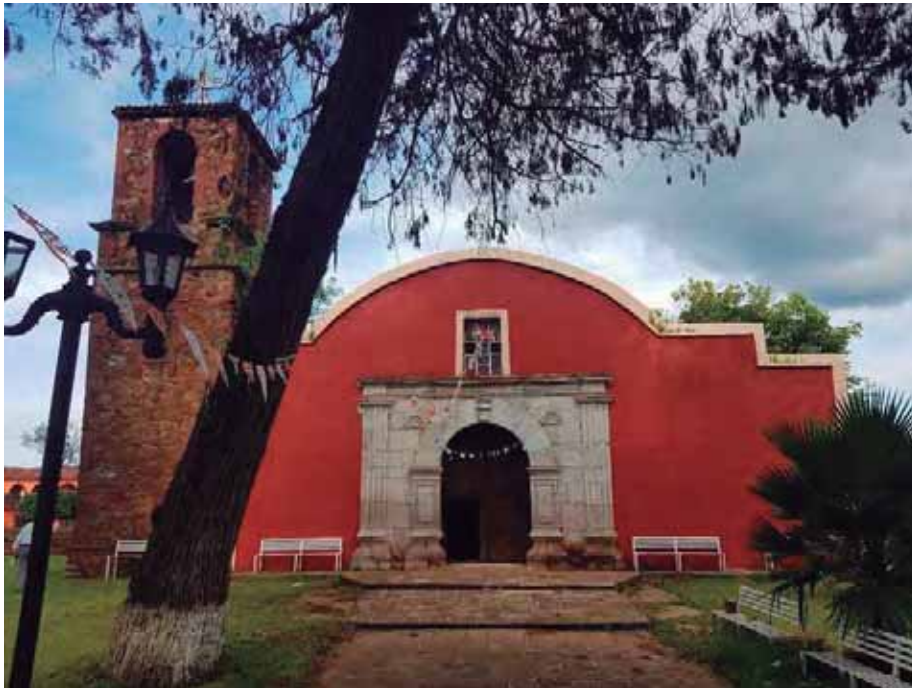
Figura 22. Fachada del Templo del Señor de la Expiración. Fotografía: Saleta Lizbeth Vargas Viveros.
