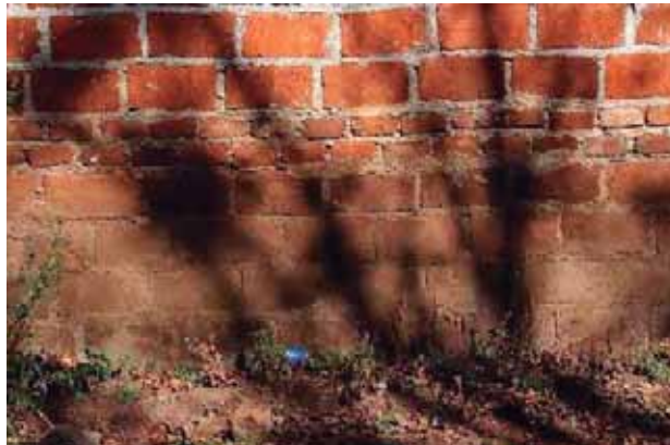
Ilustración 75. Cambio de tonalidad del ladrillo. Fotografía tomada por Ana Cecilia Martínez Cruz.
