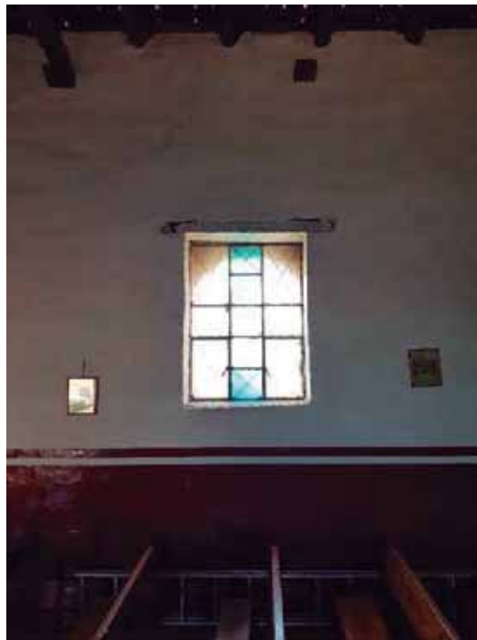
Figura 29. Vano de ventana en muro lateral de la nave. Fotografía: Saleta Lizbeth Vargas Viveros.
