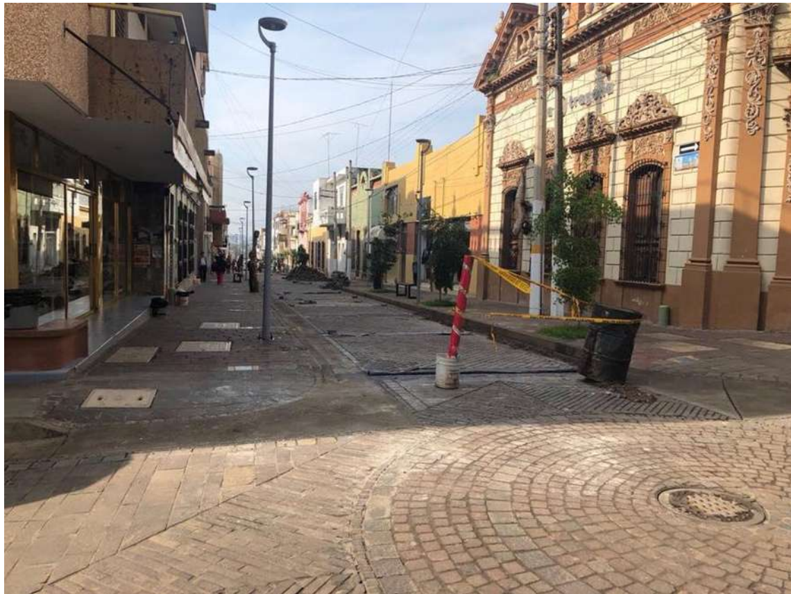
Figura 32. Trabajos de intervención en la Calle Hidalgo en su cruce con Vicente Guerrero en el 2018, donde se pueden observar los trabajos de ampliación de banquetas y preparación de registros para ocultar cables expuestos.
