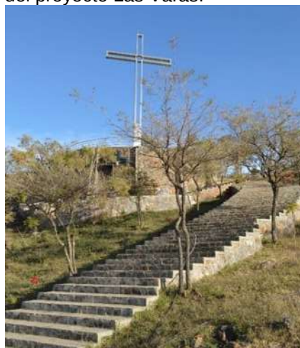
Figura 16. Avance de construcción del proyecto Las Varas.
