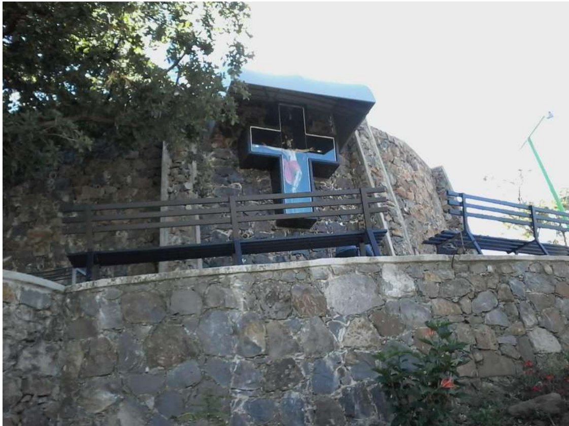
Figura 24. Fotografía de los avances en la construcción de infraestructura para los peregrinos que visiten el sitio del hallazgo en el Cerro Gordo, proyecto Las Varas.
