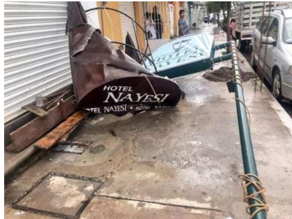
b) Anuncio espectacular colapsado
