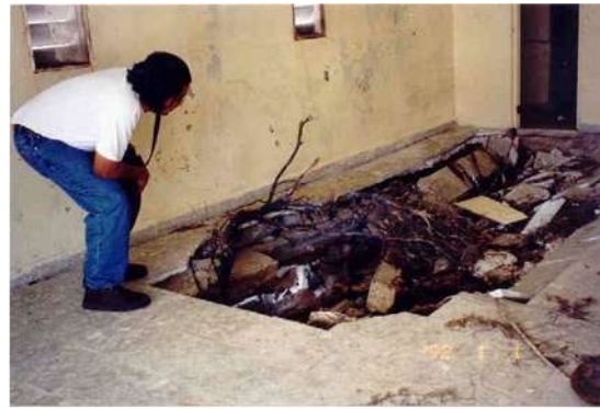
a) Árbol desprendido (Rosengaus et al. , 2002) b) Socavación de cimentación (Bitrán et al. , 2003)
