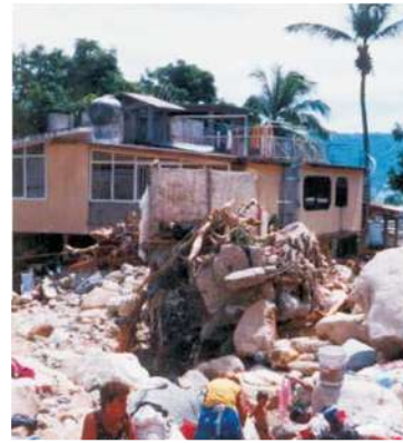
b) Flujo e escombros (Rosengaus et al. , 2002)
