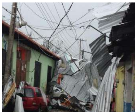
a) Daños producidos en Chiapas
