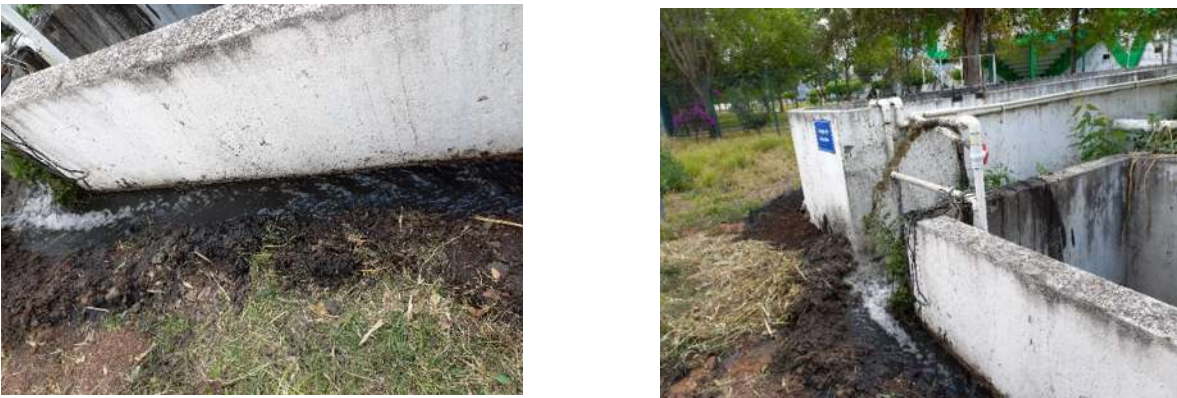
Figura 11. Canal para desagüe del tanque regulador
