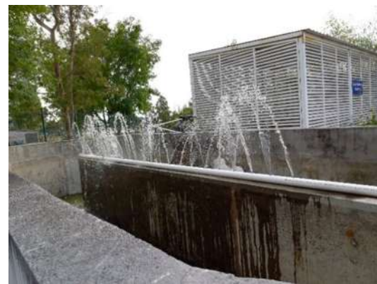
Figura 19. Cascada formada con la tubería de PVC
