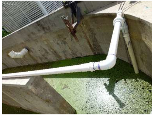
Figura 18. Tubería de la cascada colocada
