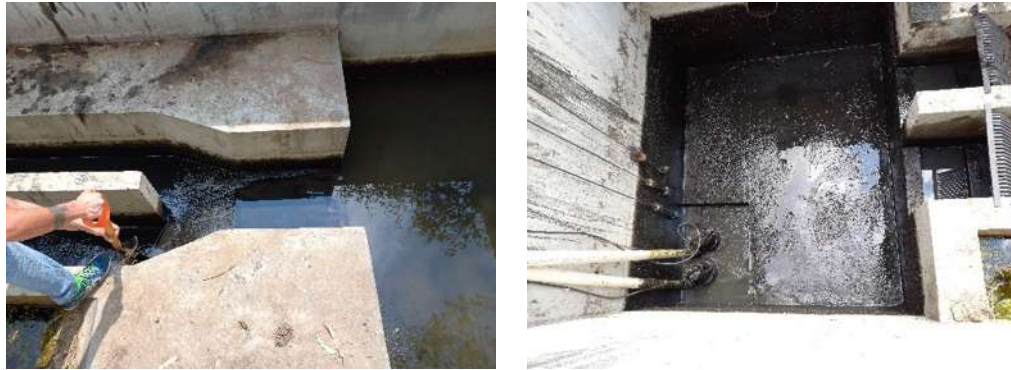
Figura 12. Limpieza del tanque regulador
