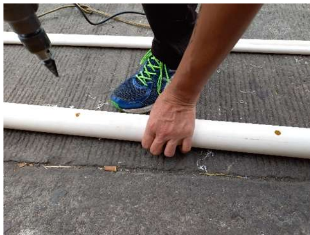
Figura 17. Perforación de la tubería de la cascada
