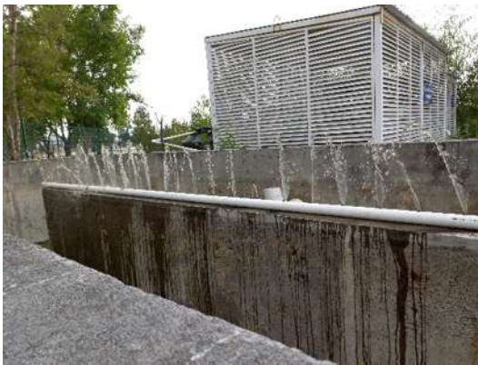
Figura 19. Cascada formada con la tubería de PVC
