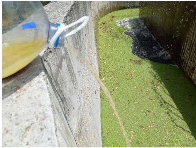
Figura 21. Aplicación de las enzimas al tanque biológico
