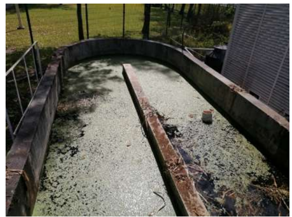
Figura 8. Tanque de tratamiento sin limpiar
