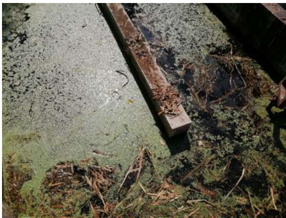
Figura 8. Tanque de tratamiento sin limpiar
