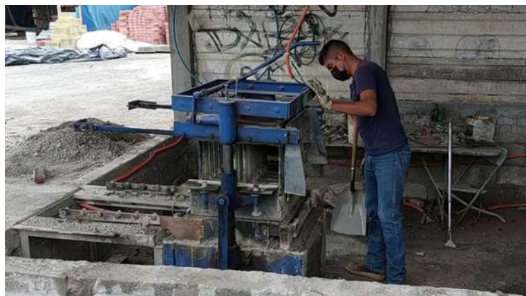
Figura 12. Vibrado y acabado de los tabicones con máquina bloquera
