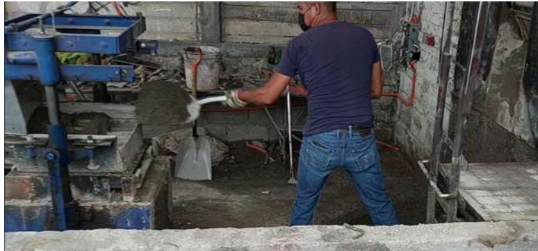
Figura 10. Vaciado con pala para albañilería.
