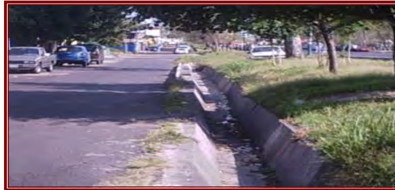
Canal de Desagüe Pluvial; 43,Imagen 74
