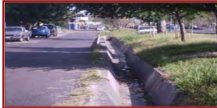
Imagen del canal de desagüe pluvial que existe; 52,Imagen 82
