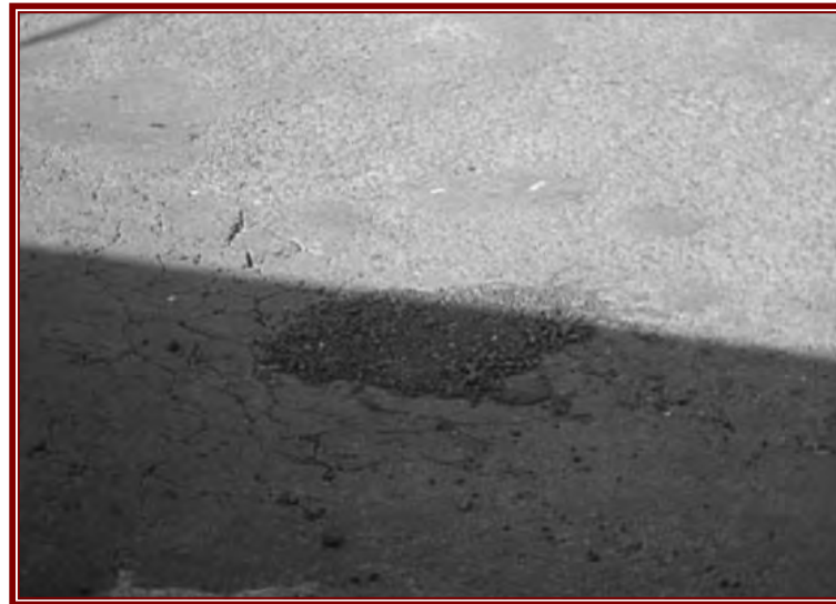
Imagen de recubrimiento de bache en vialidad; 51,Imagen 81
