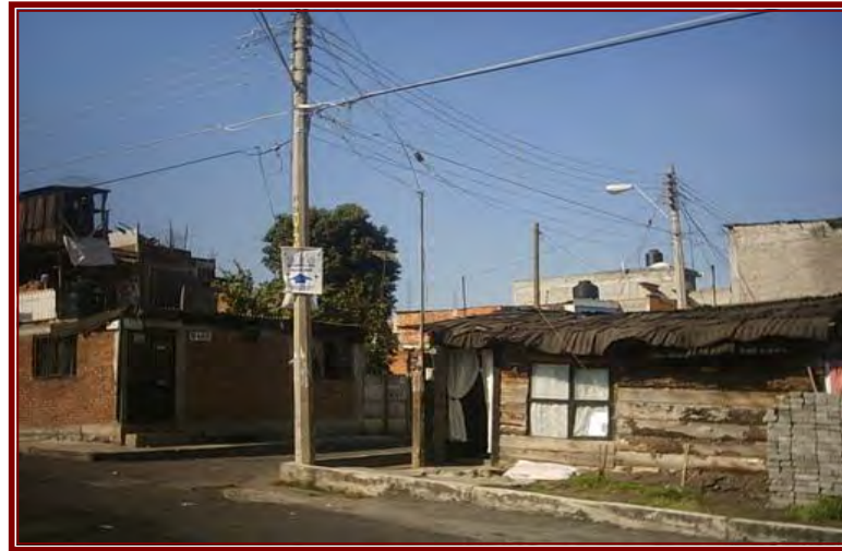
Colonia Leandro Valle que requiere un mejoramiento en su imagen urbana. 1,Imagen 1
