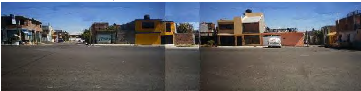
Larguillo que representa el mejoramiento de infraestructura eliminando el cableado aéreo de baja tensión
