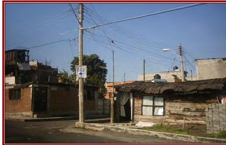
Falta de conclusión de obras 36,Imagen 67
