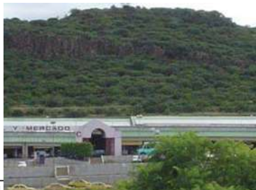
Fig.58. Central de autobuses de Querétaro
