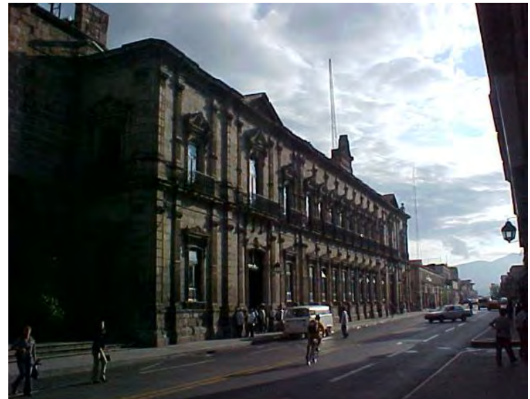
14. Construcciones residenciales, Edificio ocupado por Correos sobre Av. Madero Oriente.
