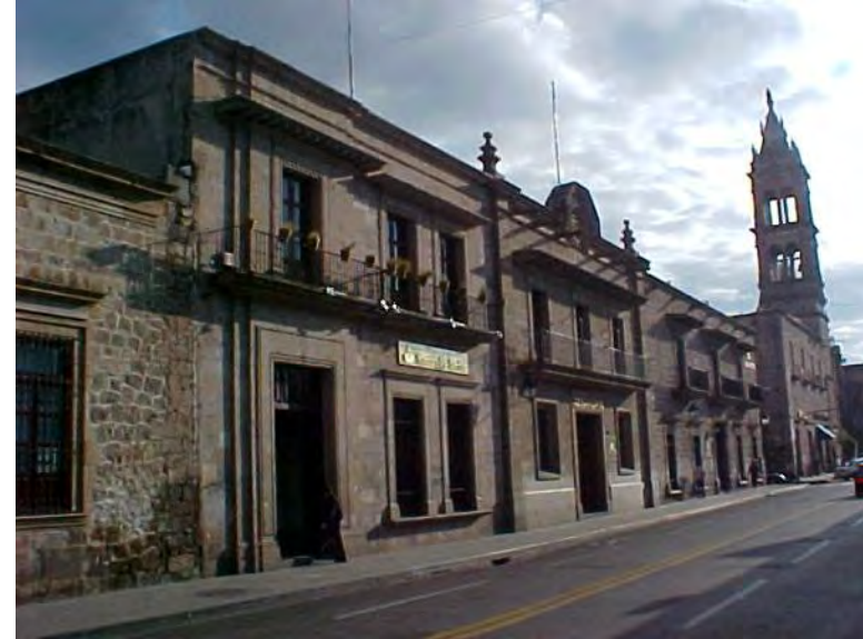
33. Centro Histórico Av. Madero Oriente
