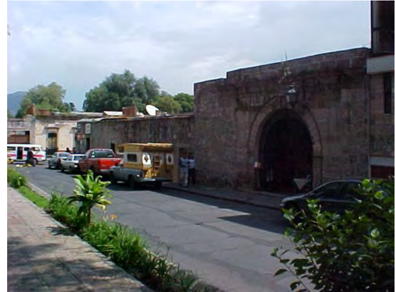
16. Casa ubicada en la calle Bartolomé de las Casas No. 652, Ejemplo de vecindad.
