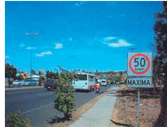
FOTO 1: En esta foto vemos el periférico independencia, que es la vialidad principal.
