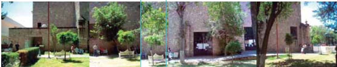
F3/ Fachada Norte
