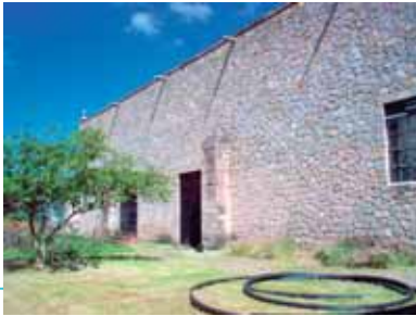
F1/ Fachada Sur
