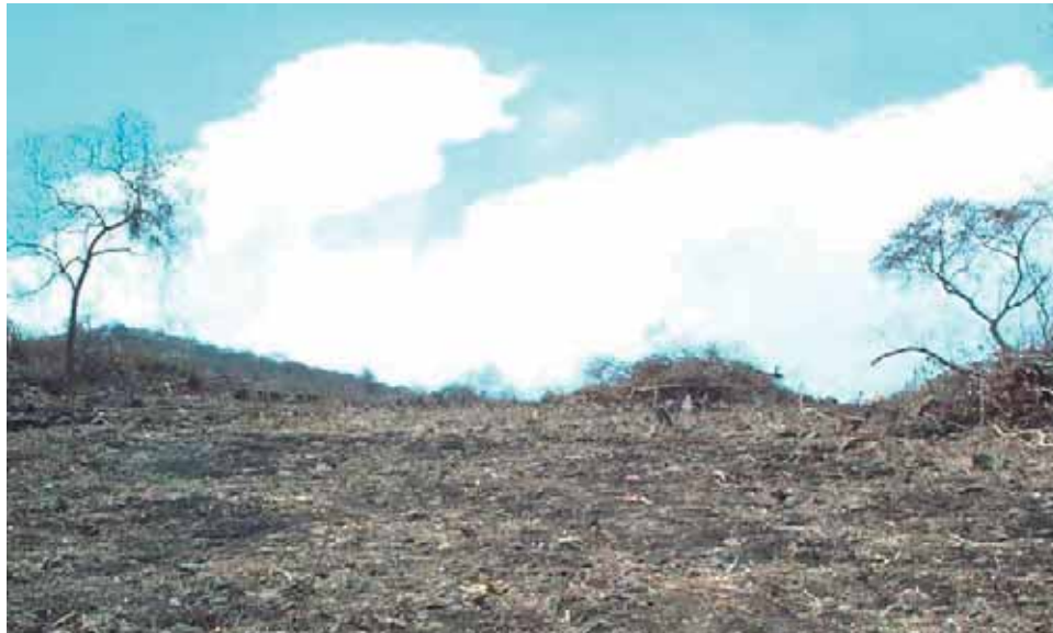
Foto 15. En esta toma fotográfica se aprecia el acceso al terreno, el camino y el terreno se encuentran en proceso de desmonte y despalme. 83
