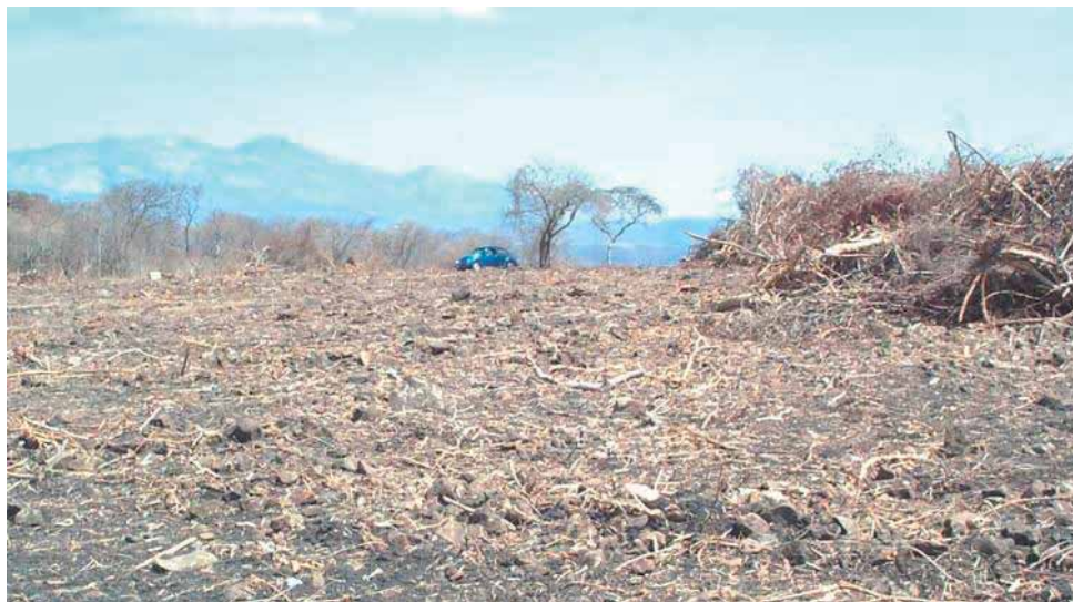
Foto 16. En esta toma se puede apreciar el terreno mismo que se encuentra en proceso de desmonte, trabajos realizados por h. ayuntamiento de Buenavista. 84
