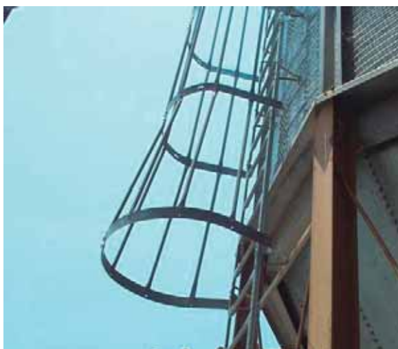
Foto 25. Una solución en el caso del mantenimiento de las cubiertas ya que tendrán la función de captación del agua pluvial, y requerir de limpieza, lo es este tipo de escalera marina con protección. 102
