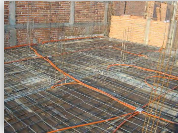
Armado de losa plana, Distribución del poliducto para la Inst. Eléctrica
