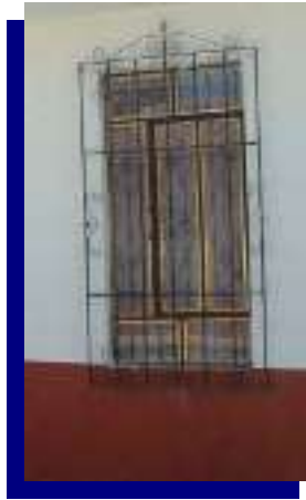
Imagen 131.- Ventana y protección de herrería.
