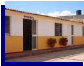
Imagen 85.- Típica construcción de ladrillo.
