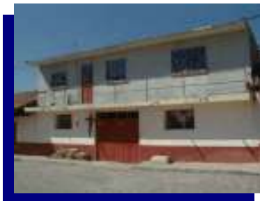
Imagen 126.- Vivienda de concreto, manzana b.
