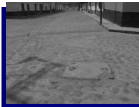
Imagen 75.- Tapa de alcantarilla
