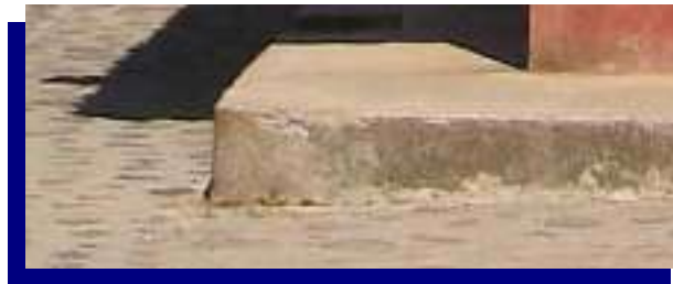
Imagen 135.- Esquina de banquetas.
