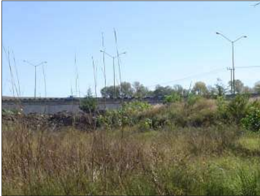
Imagen 31. En esta foto, se observan las luminarias de la carretera , y la línea de postes que se encuentran cruzando la carretera.
