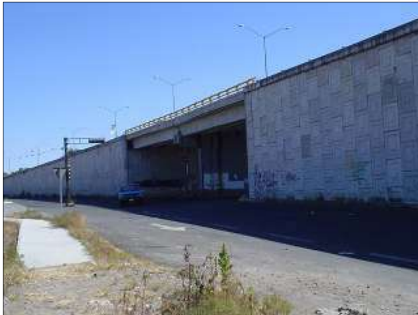
Imagen 29. Aquí se puede observar el paso a desnivel, el cual es una gran masa de piezas prefabricadas de
