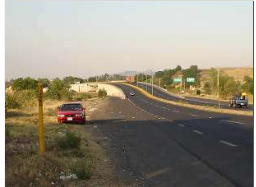
Imagen 34. En esta imagen se observa la carretera Morelia-Pátzcuaro, así como el puente por donde pasa la vialidad hacia Tenencia Morelos.
