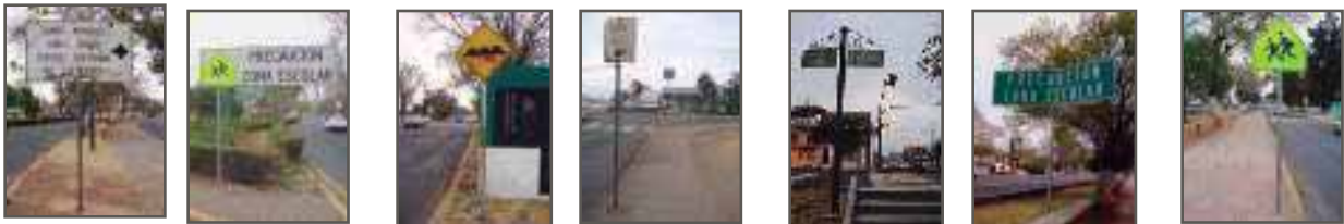
Fig.53. Existe una gran variedad de letreros, lo que nos dicta que debemos de homogenizar la señalética para lograr una mejor imagen de la Calzada Juárez. La mayoría de ellos se encuentran oxidados, borrosos y mal ubicados.
