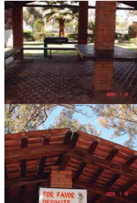
Fot.-20 Detalle de cenador (materiales de construcción.) 21
