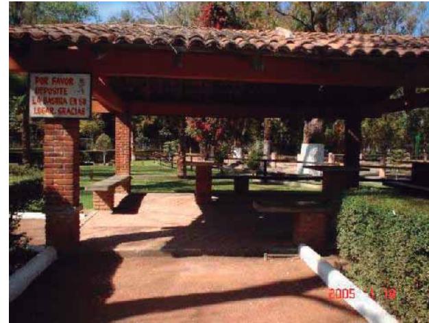
Fot.-23 Detalle de cenador (materiales de construcción.) 24
