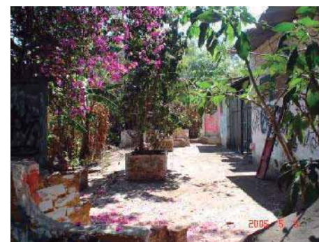
Vivienda abandonada, ocupada por bandas de delincuentes encontrándose totalmente graffiteada.
