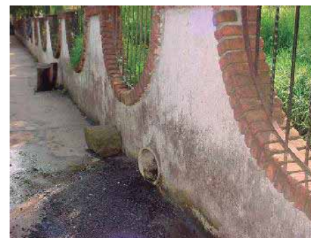
FOT.- 39 Desemboque de agua pluvial del área de estudio (Cenadores de Sta. María). 29
