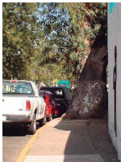
Árboles mal ubicados.
