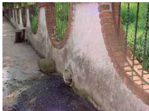
Desemboque de agua pluvial en banquetas.
