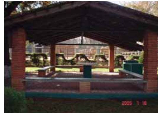
Fot.-22 Detalle de cenador (materiales de construcción.) 23
