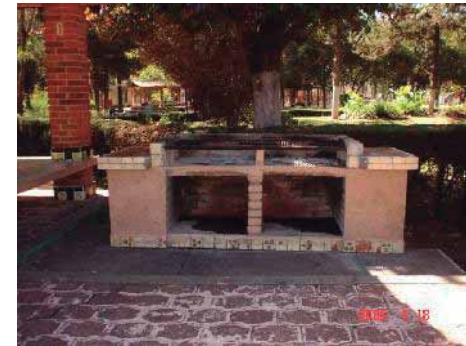
Fot.-23 Detalle de cenador (materiales de construcción.) 25
