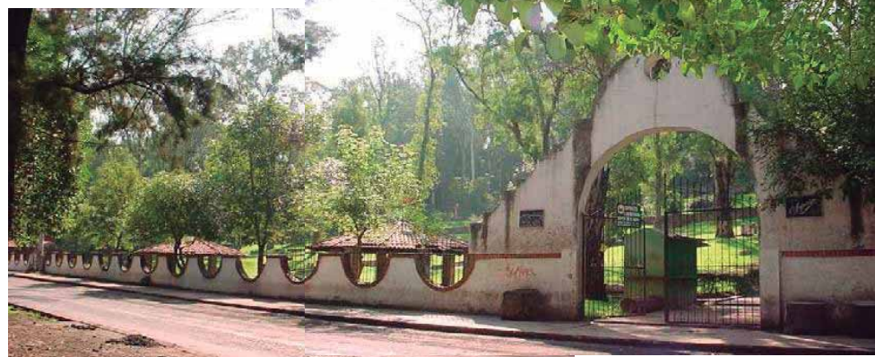
FOT.- 37 Acceso principal de área de los cenadores de Sta. María 21
