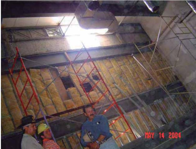
Armado de muros acústicos en salas
