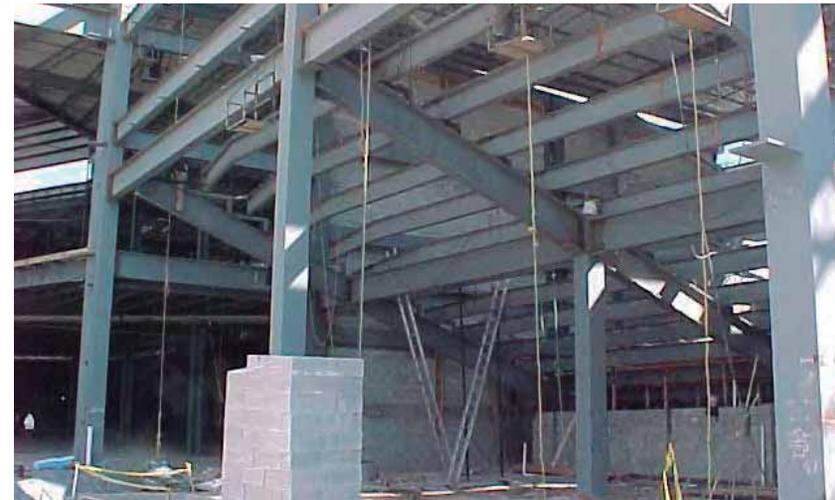
Estructura primaria del sistema de gradería en salas, y su elementos de soporte vertical (columnas)
