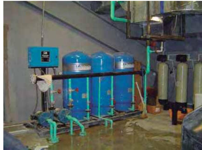
Sistema de bombeo. 2 bombas centrífugas, 3 tanques hidroneumáticos, panel de control y cabezal de descarga.
