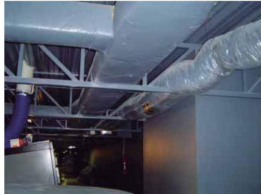
Ductos de aire acondicionado en las casetas de proyección. Los ductos se recubren de fibra duckliner de 1" para aminorar el ruido. La estructura se diseña contemplando el paso de los ductos a través de ella. El ducto redondo es de extracción de aire caliente del espacio. El ducto azul de la izquierda es la extracción de aire de un proyector.
