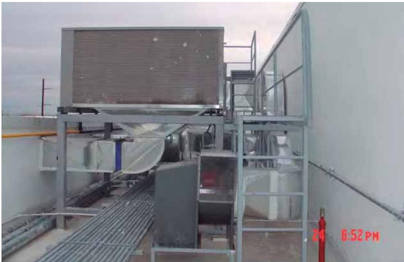
Unidad paquete de aire acondicionado. La paquete se eleva para permitir que los ductos de aire entren de manera horizontal al espacio de la sala. El equipo al centro de la imagen, en la parte inferior, es un extractor de aire de las casetas. La estructura de la derecha es un paso de gatos, para el paso peatonal.
