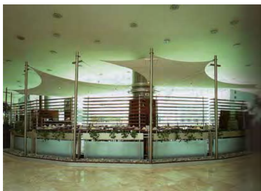
FOTO 32.- Las tensoestructuras pueden actuar en los espacios haciendo las veces de techos, utilizando telas y postes decorativos para tensarlas. Fernando de Haro, Omar Fuentes. (ideas, ESPACIOS).
