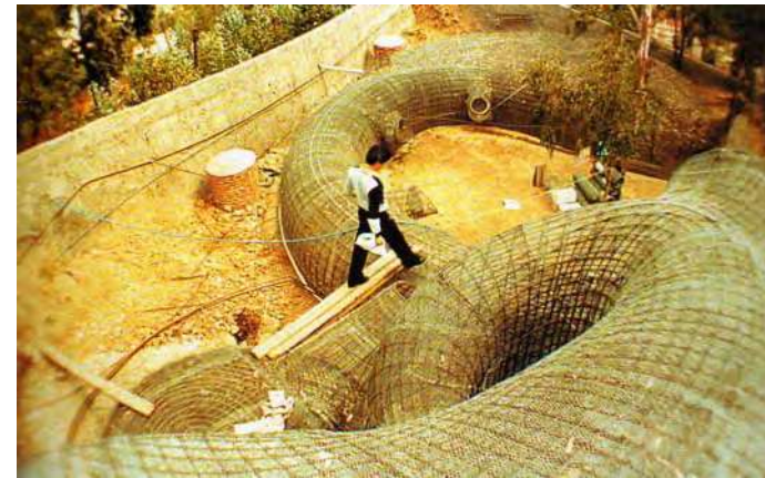
Foto 20, 21 y 22. - Esqueleto metálico cubierto con mallas de gallinero y reforzado con varillas que se entretejen al mismo. Senosian Javier (BIOARQUITECTURA en busca de un espacio).
