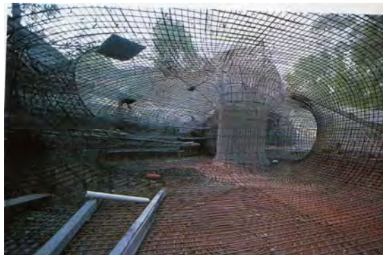
Foto 20, 21 y 22. - Esqueleto metálico cubierto con mallas de gallinero y reforzado con varillas que se entretejen al mismo. Senosian Javier (BIOARQUITECTURA en busca de un espacio).
