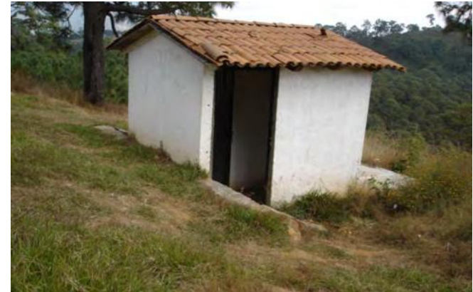
Foto 13.- Servicios Sanitarios Existentes
