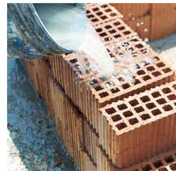
La adecuada adherencia entre mortero y ladrillos se logra si éstos se mojan a saturación previamente a su pegado.
