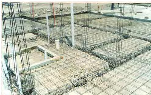
Forma común de anclaje, en este tipo de cimentación, de los castillos electrosoldados o castillos habilitados en obra con varillas comerciales. Compatible con todo tipo de estructuras de cimentación y losas.
