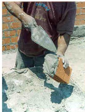
El siguiente TABIMAX se coloca aplicándole el mortero en toda la superficie de la cara lateral, esta operación se repite para todos los tabiques. De esto dependerá en gran medida, la resistencia de la mampostería.
