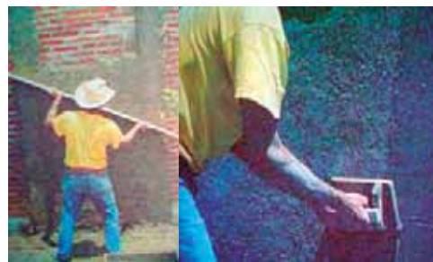
Imagen No. 46.- Repellado y aplanado de mortero.
