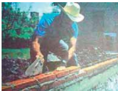
Imagen No. 45.-Elaboración de un Muro de Tabique.
