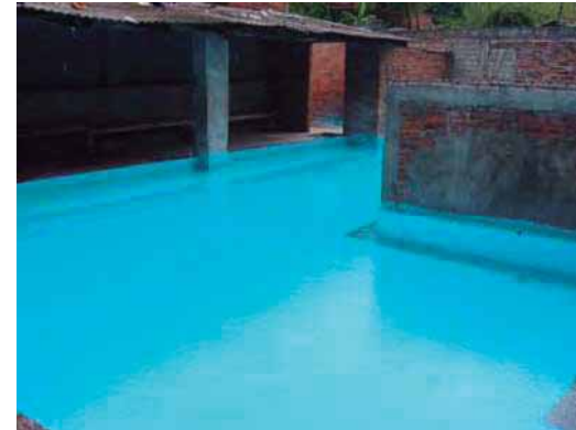
Ilustración 10.- Alberca (Los Baños)
