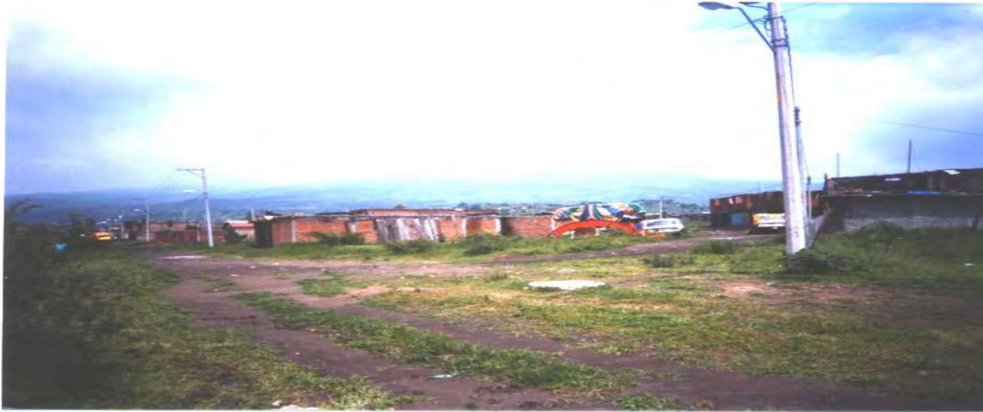
Fotografía # 3 vista norte al fraccionamiento Valle de los Manantiales en el cual se observa también la vivienda tipo predominante. La infraestructura colindante: línea de electrificación y las alcantarillas de la red del drenaje.
