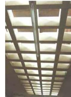
**17.- Sistema constructivo en techo a base de estructura reticular de concreto armado, Mercado Revolución.**
