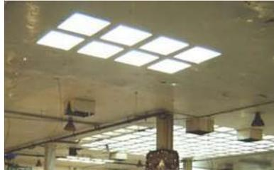
32- Sistema constructivo a base de losa de concreto y domos, Mercado Independencia.
