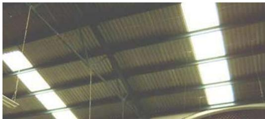
33- Cubierta de estructura metálica y lámina, Mercado Independencia.
