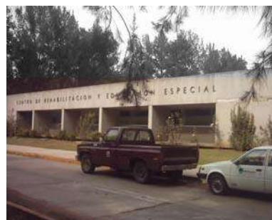
Fachada del CREE Morelia
