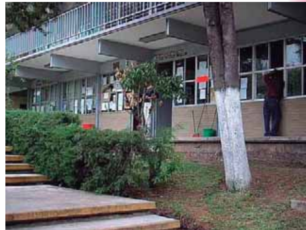
FOTO 44 Fachada de dirección, control escolar, auditorio, área administrativa
