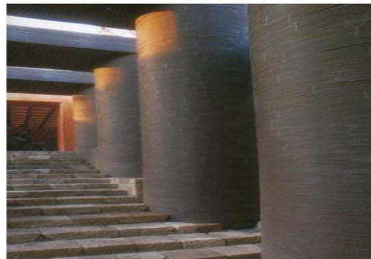
Fig. 19. Columnas circulares revestidas de alambra.
