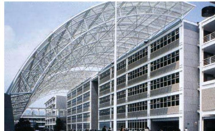
Fig. 22. Vista de una tridilosa, que sirve como barrera al paso de los rayos solares y que entran directamente a las diferentes áreas del inmueble, también se emplea como cubierta de espacios abiertos.
