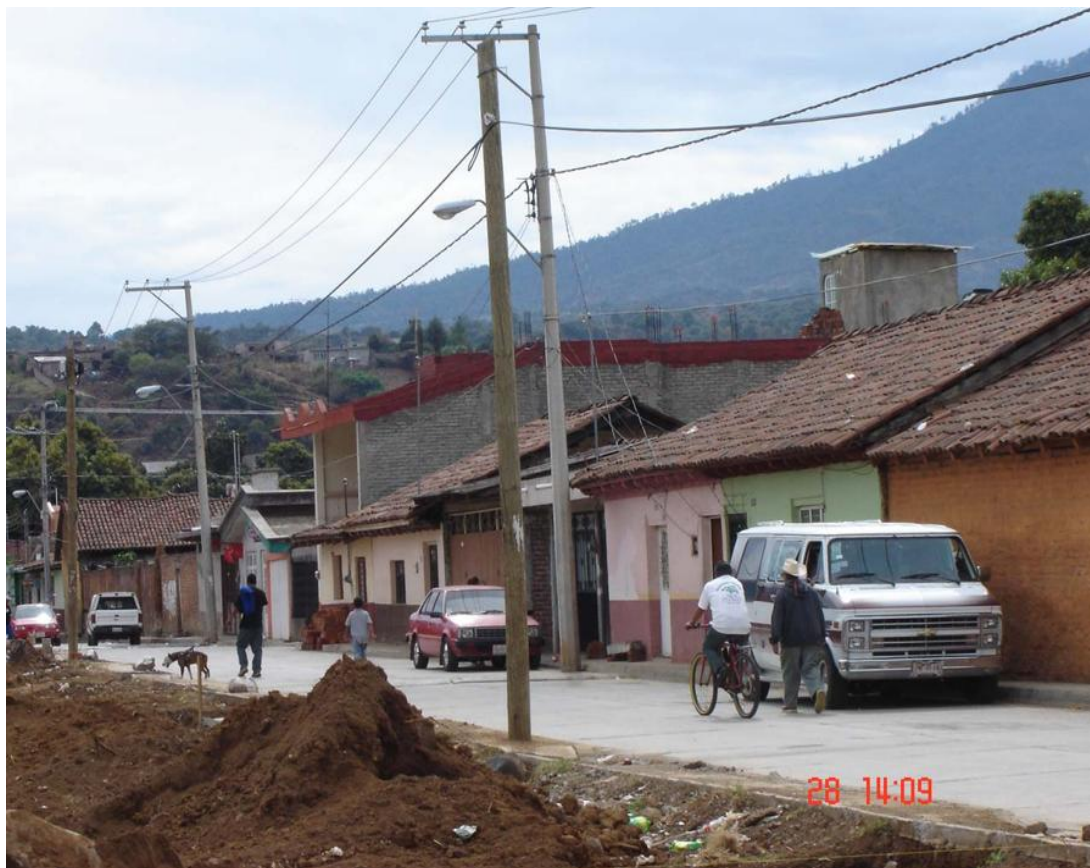
Postes de energía eléctrica frente a terreno 31
