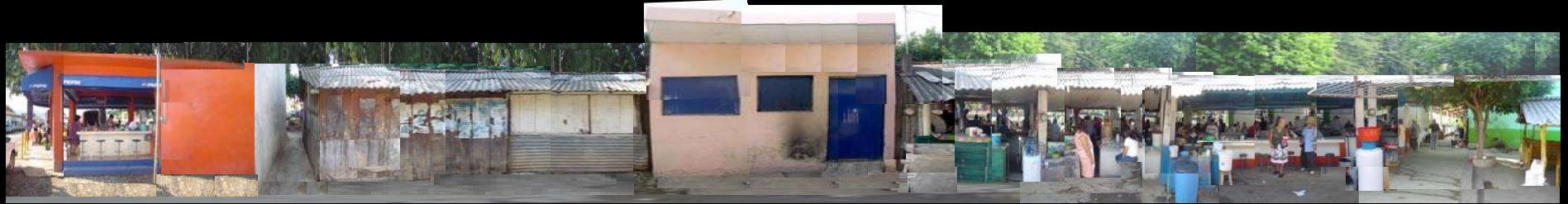
Corredor 2-A Vista Frontal
