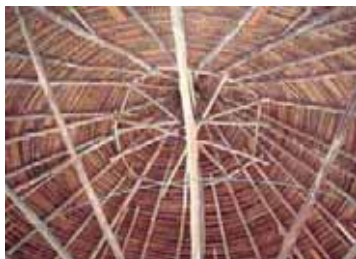
IMAGEN 41. Estructura de un techo en cabaña.
