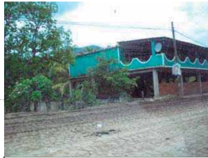
IMAGEN 9. Vivienda actual de concreto. A dos niveles.
