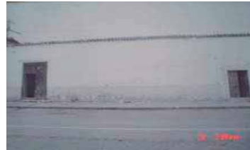
Avenida Vasco de Quiroga. Fotografía: Sr. Ruben
