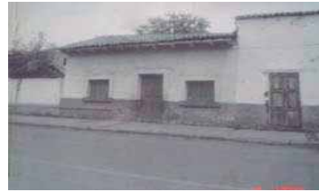
Avenida Vasco de Quiroga. Fotografía: Sr. Ruben
