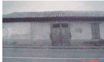
Avenida Vasco de Quiroga. Fotografía: Sr. Ruben
