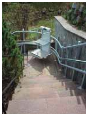
048.- Imagen del escalador de escaleras, se observa como es adaptable a todo tipo de escaleras y no ocupa mucho espacio, de modo que sin estar en funcionamiento es plegable.
