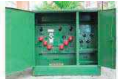
045.- Transformador tipo pedestal marca Rymel
