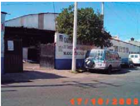
014.- En esta imagen se puede observar las fachada y el descuido que presenta la cartonera de Morelia, a parte que esta ubicada en la esquina que forman Manuel Muñiz y Mariano Michelena y esto hace que se entorpezca el transito
