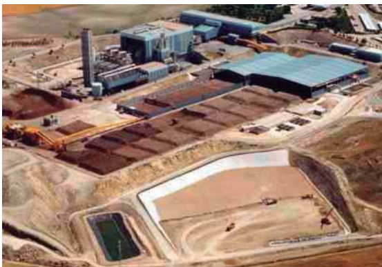
008.- Instalaciones del centro de tratamiento integral de Residuos "las lomas" en Madrid España.
