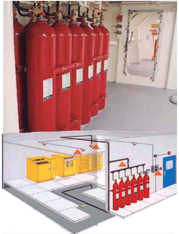
042.- En esta ilustración se observa parte del sistema contra incendio de tipo "B" en adelante, hasta el tipo "D" (a utilizar), también se observa una ilustración que muestra su funcionamiento. Información obtenida en http://www.famaseg.com
