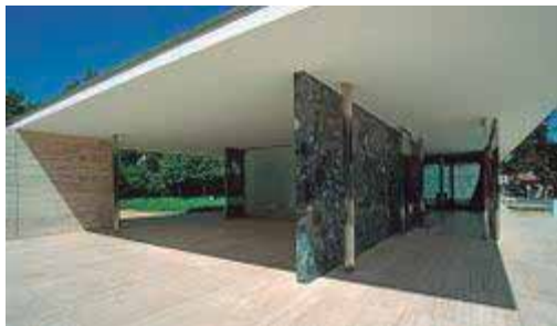
Pabellón de Alemania en la Expo de Barcelona
