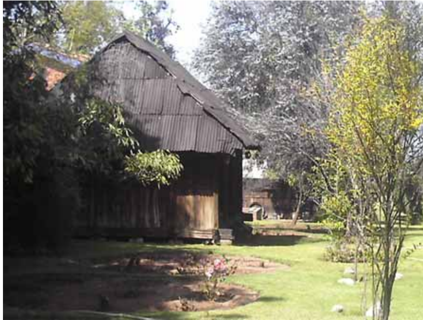
Vista lateral de las trojes
