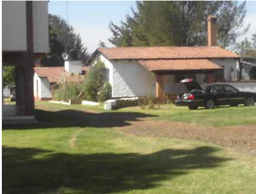
Vista interior de las casas dentro del condominio
