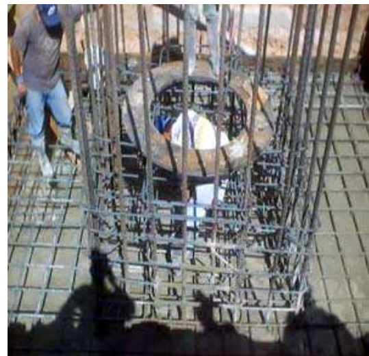
043.-Zapatas Aislada y Dado. FUENTE: Ver índice de imágenes.
