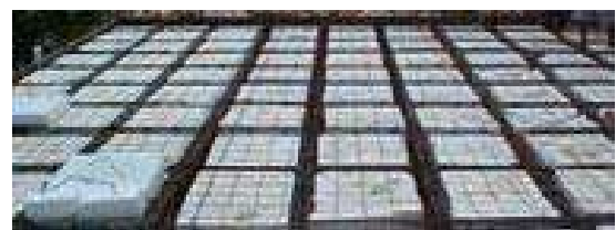
052.- Fotografía de Losa Reticular. FUENTE: Ver indice de imágenes.
