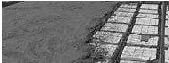
053.- Fotografía de Losa Reticular al momento de ser colada. FUENTE: Ver índice de imágenes.
