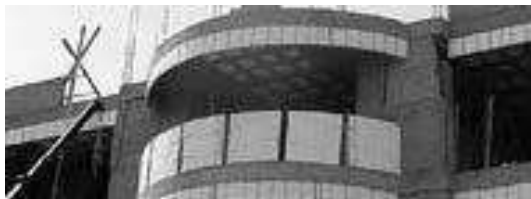
044.-Construcción con panel w. FUENTE: Ver índice de imágenes.
