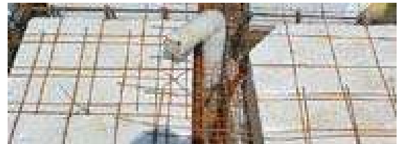
054.- Bloque de poliestireno expandido de tamaño ajustable de acuerdo con las dimensiones y espesores requeridos por el diseño, que se corta a la medida, suministrándose a la obra ya listo para su colocación. FUENTE: Ver índice de imágenes.
