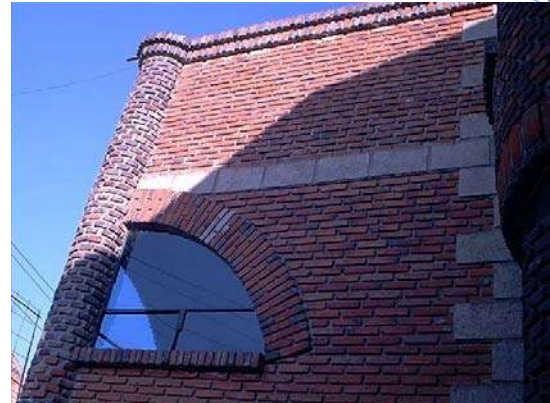
051.-Imagen de muros de tabique recocado. FUENTE: Ver indice de imágenes.
