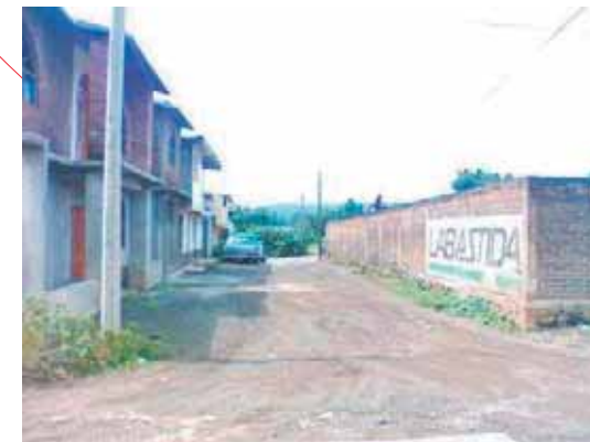
Fig. 76 Calle Secundino Sosa*
