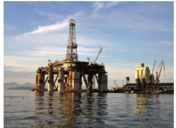
11. Plataforma Petrolera en Construcción en las costas de Brasil
