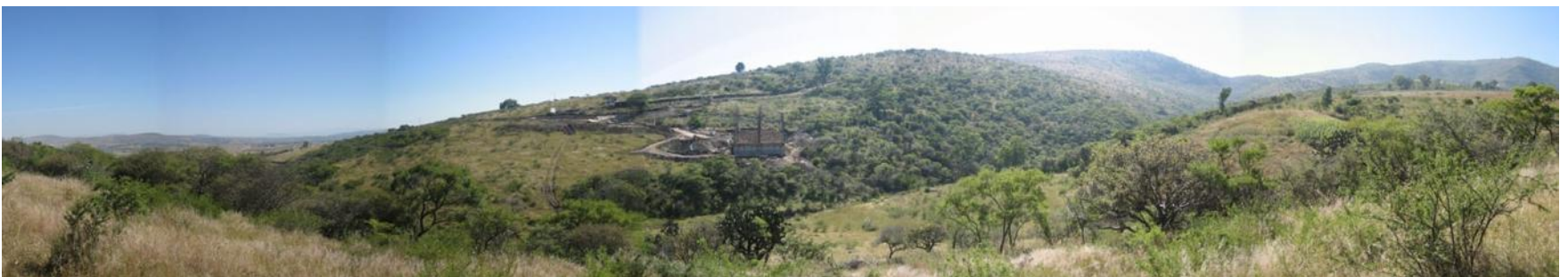
51. Panorama c. Desde la parte Opuesta, es decir, desde el oeste de la Cañada, se observa el Módulo 1.
