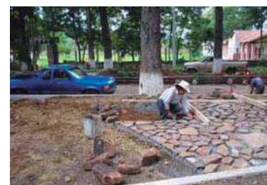
Foto 35. Ejemplo de trabajo de empedrado en piso. 31
