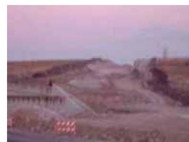
Foto 34.- Imagen del camino en construcción.
