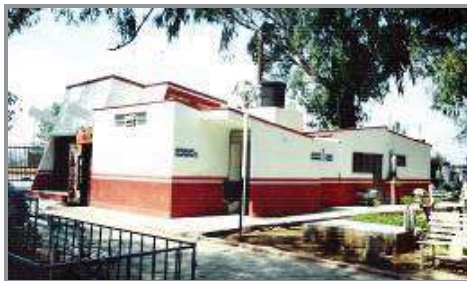
Núcleo 2 de Sanitarios en la parte sur, cercano a la puerta de acceso
