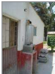
Vista exterior del acceso a la bodega de
