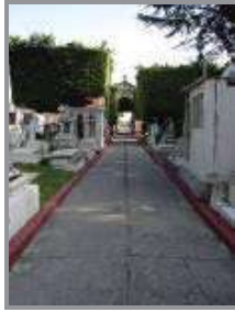
Superficie de concreto en el eje principal sur - norte.
