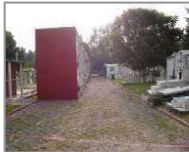
Superficie adoquinada. área suroeste del panteón
