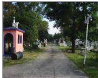
Superficie de concreto en vialidad Primaria
