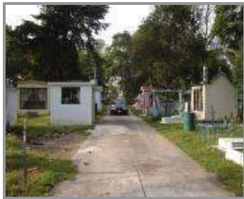
Superficie de concreto en circulación de eje norte-sur.
