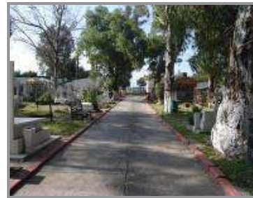
Superficie de concreto en el eje principal norte-sur.
