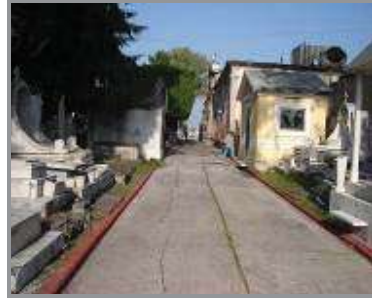
Superficie de concreto en vialidad Primaria
