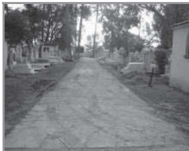
Superficie de concreto en vialidad Secundaria
