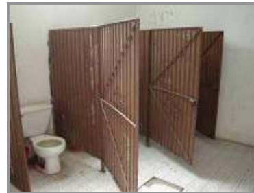
Vista interior de del núcleo 2 de Sanitarios en la parte sur, cercano a la puerta de acceso.
