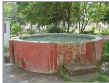
Pila de agua, en el área sureste
