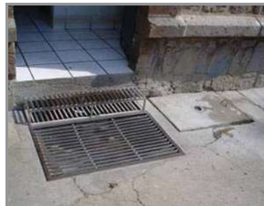
Registro de descarga de núcleo de sanitarios en el área de frontispicio y coladera
