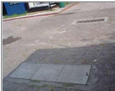
Registro de descarga de núcleo de sanitarios en el área de anexo
