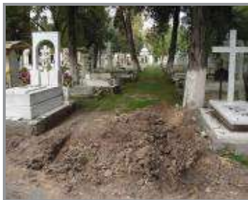
Superficie de Terracería, en el cruce de circulaciones al este del panteón.
