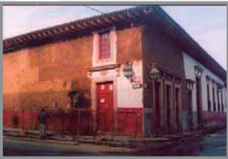
l no. 14 Proceso de aplanado a base de lodo.
