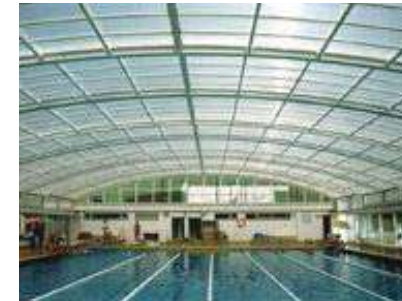
IMAGEN 66. En esta imagen podemos observar la utilización de las placas de policarbonato en cubiertas.
