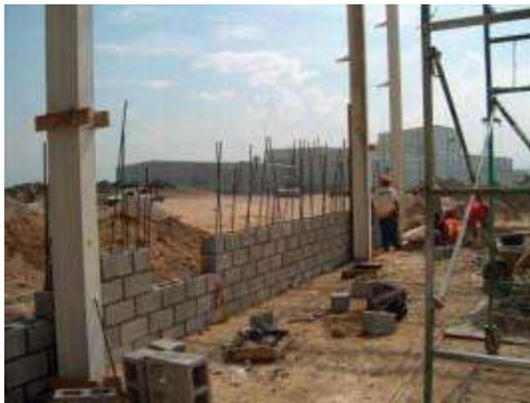
IMAGEN 61.- Construcciones realizadas empleando block de concreto.
