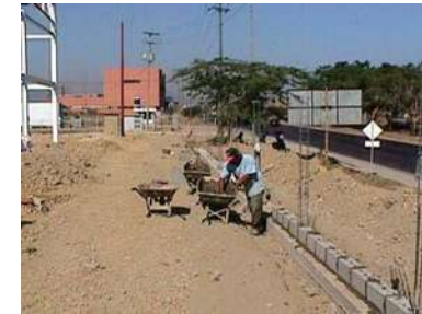
IMAGEN 60.- En esta imagen podemos observar como se van colocando las piezas de block, para conformar un muro.
