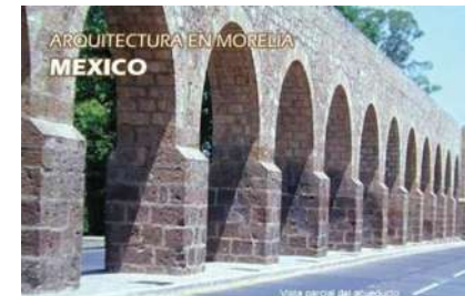
IMAGEN 32. Acueducto de la Cd. De Morelia Michoacán.
