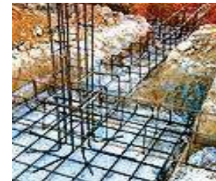
IMAGEN 56.- Esta imagen nos presenta el armado de una zapata aislada, cada una de ellas es unida con otra por medio de una trabe de liga.
