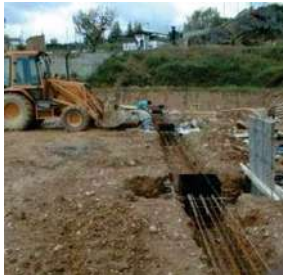
IMAGEN 55.- En esta imagen podemos observar las excavaciones que se realizan para una cimentación, estas dependiendo de sus dimensiones se pueden realizar en forma manual por un albañil, o por medio de maquinaria.
