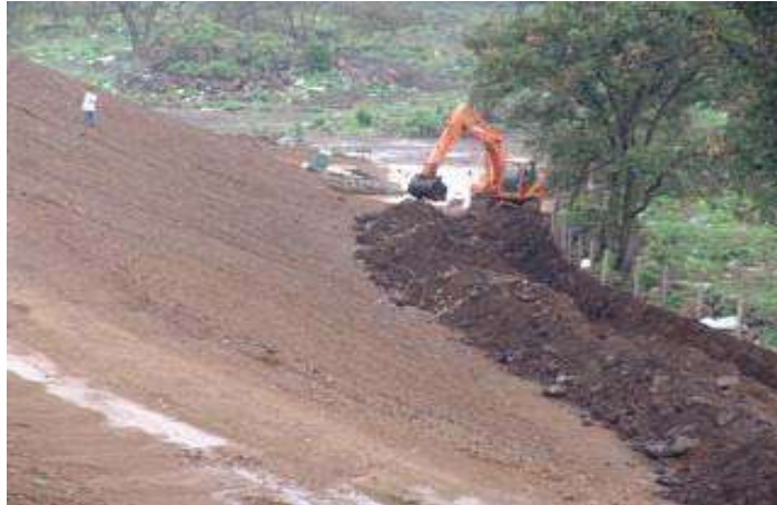
Imagen C).- En esta imagen podemos observar la construcción del canal de aguas pluviales que rodeará al tiradero de basura, además se instalarán 53 ductos que quemarán de manera permanente el gas que genera el relleno sanitario.
