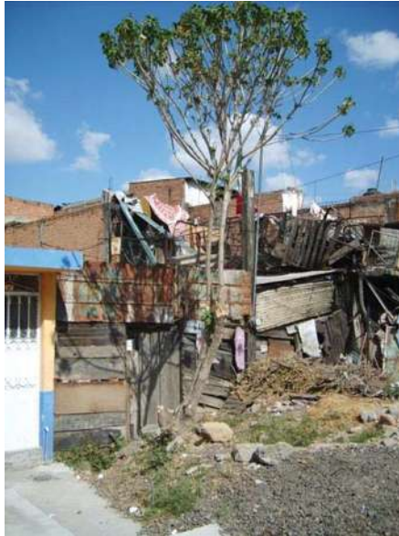
Imagen L). - En esta imagen podemos observar que este centro se encuentra en medio de casas habitación, donde es imposible controlar la proliferación de roedores, además de que es un riesgo para la salud, toda esta acumulación de desechos.
