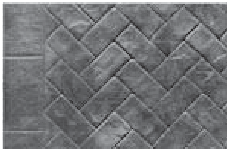
Imagen N°28 Adoquinado de loseta prefabricada con material pétreo, Caracterizado por su aspecto apropiado para el pavimento en aceras.
