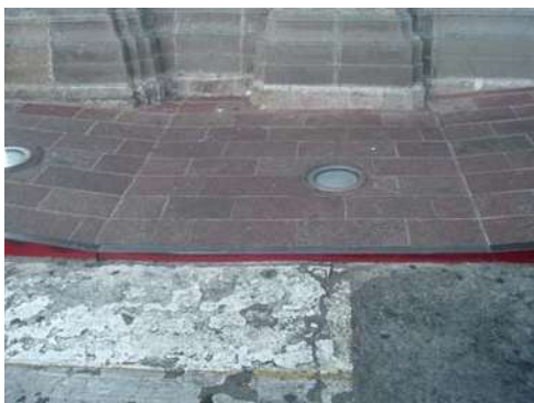
Imagen N°30 Embaldosado de pórfido que se ha estado colocando en la zona del Centro Histórico por etapas.
