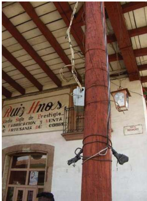
65.-Desorden en el cableado aéreo, e invasión de elementos originales. Portal Matamoros
