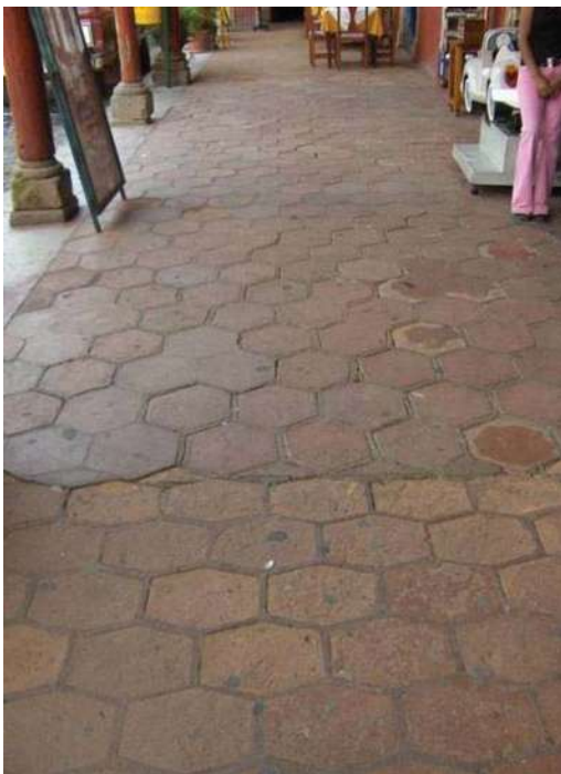
57.-Pavimentos de barro recocido en mal estado, Portal Matamoros
