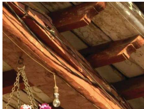
63.-Arquitrabe, vigas y cornisas de madera dañadas por humedad y factores climatológicos,
