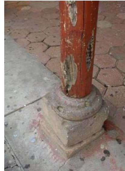
60 y 61.-Bases de cantera y columnas de madera dañadas y desfasadas, Portal Matamoros
