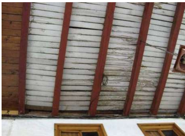
62.-Viguería y duela de madera dañada por humedad en plafón del Portal Matamoros.
