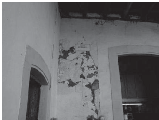
67 y 68.-Evidencias de cromatografía variada en fachadas del Portal Matamoros, obtenida por diversas calas en los aplanados.
