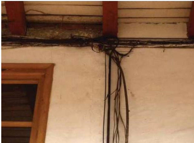
64.-Contaminación de fachadas por cableado eléctrico, Portal Matamoros
