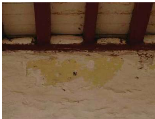
67 y 68.-Evidencias de cromatografía variada en fachadas del Portal Matamoros, obtenida por diversas calas en los aplanados.
