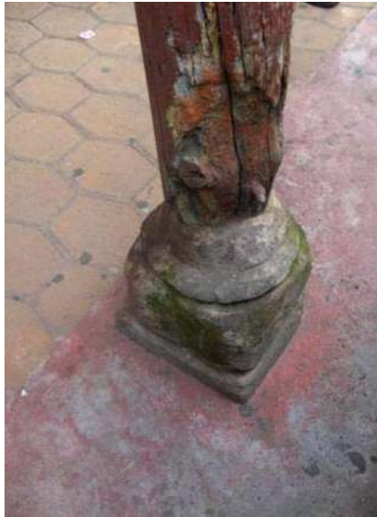
60 y 61.-Bases de cantera y columnas de madera dañadas y desfasadas, Portal Matamoros
