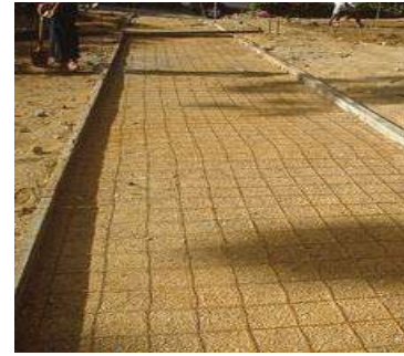
Ilustración 89: Malla de refuerzo en firmes. Fuente: Goggle Images.
