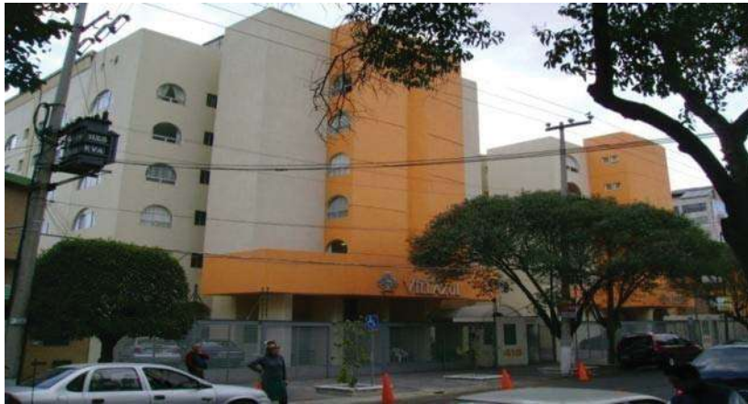
Ilustración 34: Fachada de la residencia.
