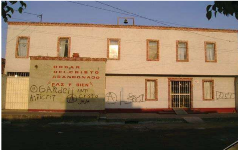
Ilustración 11: Fachada del albergue. Fuente: Autores del documento.
