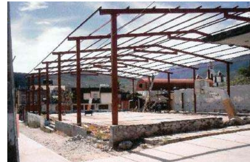
Ilustración 84: Estructura de Largueros y Travesaños. Fuente: Goggle Images.
