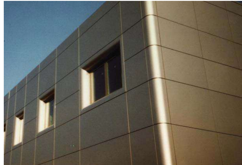
Ilustración 87 Fachada con panel alucobond color arena brillante Fuente: Folleto de Alucobond.
