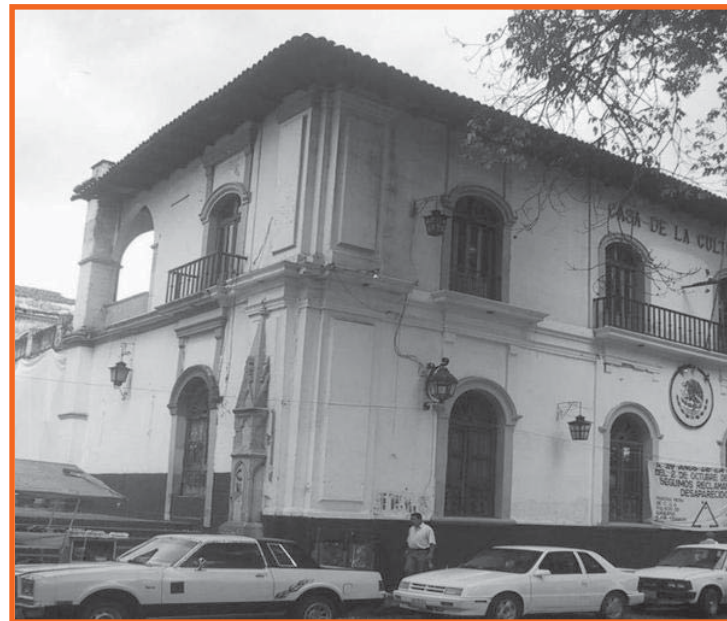
Fachada Oeste Casa de la Cultura
