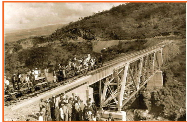
Construcción de la Vía del tren
