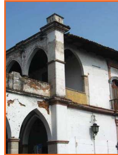
Detalle fachada Poniente
