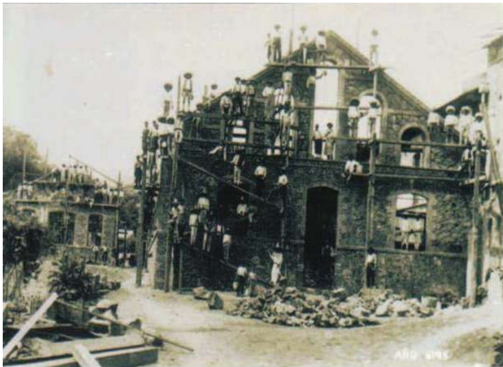
Construcción Fábrica de San Pedro
