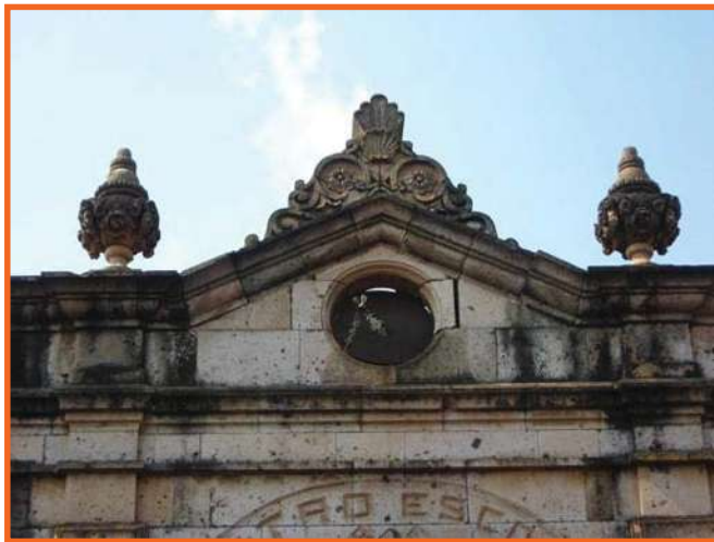
Detalle de Fachada
