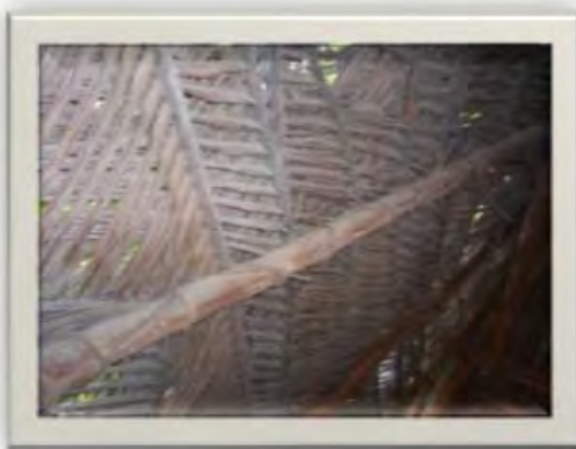
Figura 32. Muestra el sistema de amarres de la palma y su disposición horizontal. Fotografía: Luís Torres Garibay.
