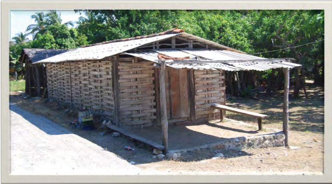
Figura 43. Muestra los cimientos de piedra brasa, las techumbres de lamia de asbesto, además del remate de teja que en ningún otro ejemplo se ve. Fotografía: Luís Torres Garibay.
