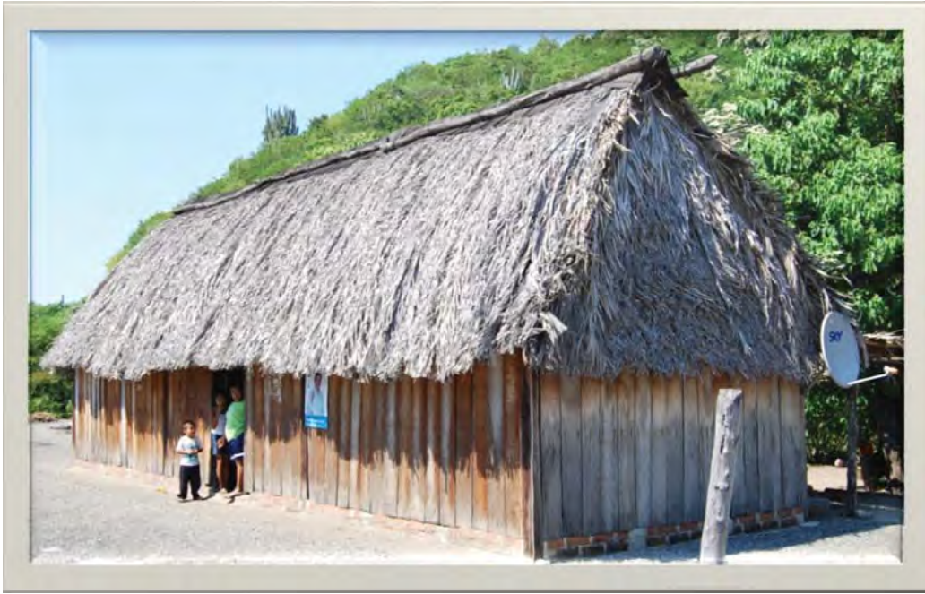
Figura 41. Muestra Los desplantes sobre la aeropista solo enterrando los postes y maderas acerradas. Fotografía: Luís torres Garibay.
