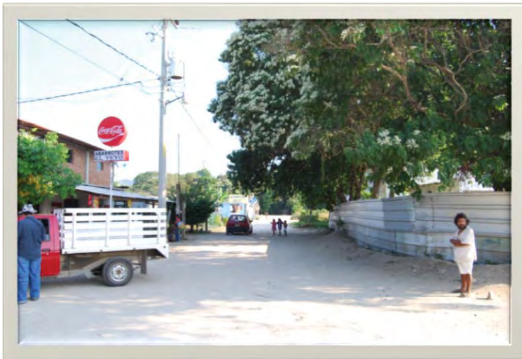
Figura 15. Vista de la infraestructura eléctrica y condiciones de las calles de Maruata. Fotografía: Luis Torres Garibay.
