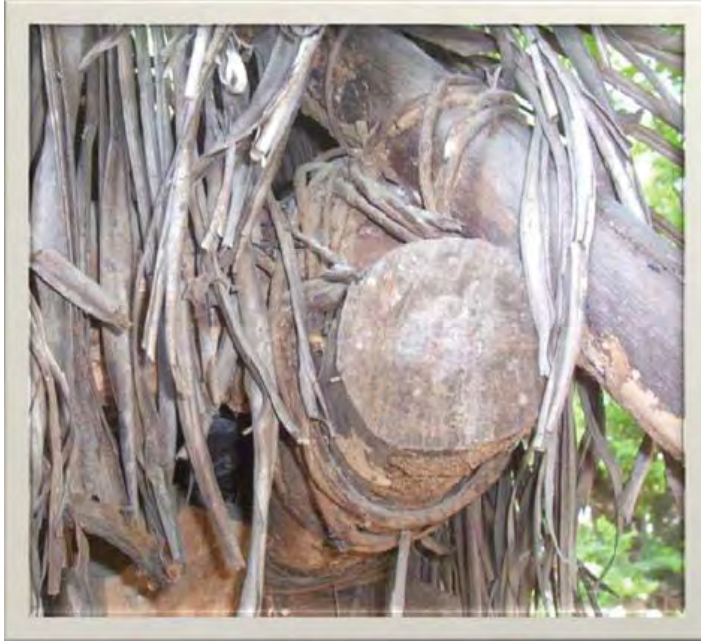
Figura 34. Muestra los amarres con enredaderas los cuales ya no se ven en ninguna otra de las viviendas. Fotografía: Luís Torres Garibay.
