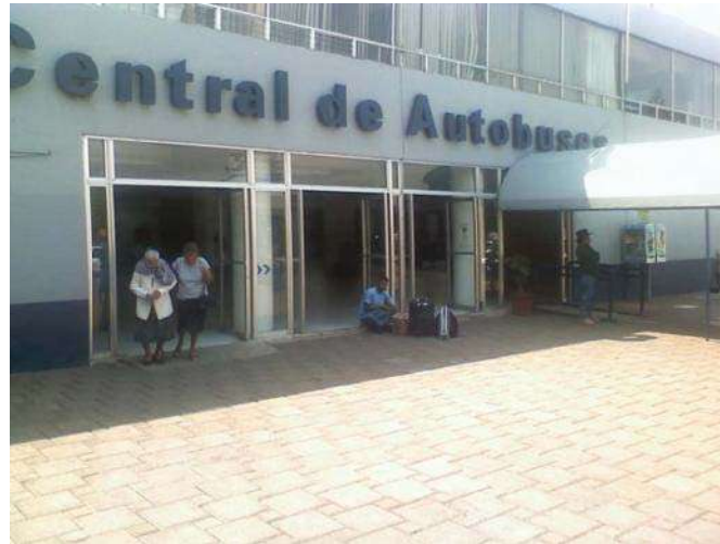
Fotografía 1.- Acceso principal de la Central de Autobuses 6
