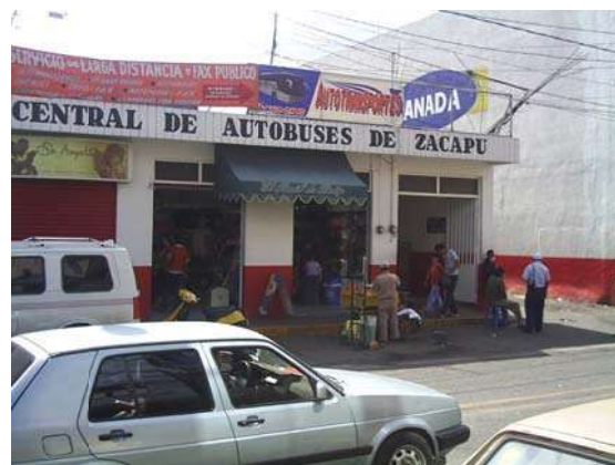
FOTOGRAFÍA 5.- Fachada principal del edificio.
