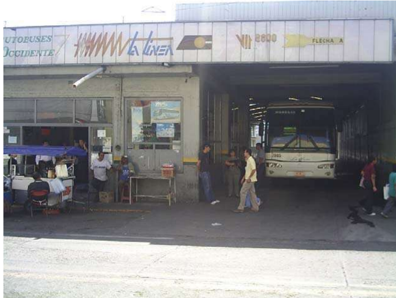
FOTOGRAFÍA 1.- Fachada principal de la terminal
