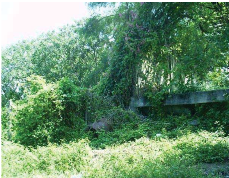
(I.3.5 Foto 11) Vista de construcciones vecinas
