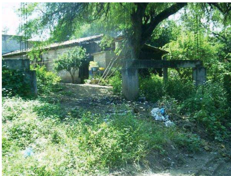
(I.3.5 Foto 12) Vista de construcciones vecinas
