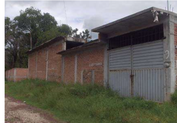
Imagen 35-Construcciones de Casas -habitación en la calle de acceso a Dreams/fuente/EJAH.
