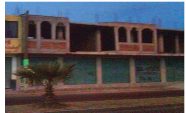
Imagen 113-Contexto urbano construcciones en proceso/fuente/FJAH.
