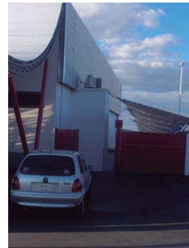
Imagen 76- Acceso de servicio peatonal y vehicular/fuente/EJAH.
