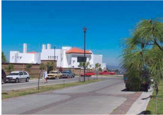
Imagen 48- Casa habitación de un fraccionamiento cercano al antro/fuente/FJAH.
