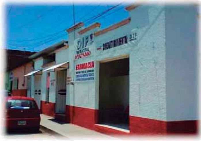
Ilustración 26 Fachada del DIF de Huetamo Fuente: Autor del documento
